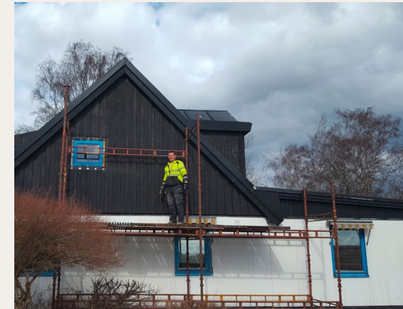
Umbauarbeiten an der Klosteranlage im schwedischen Norraby
